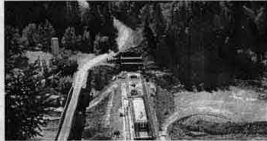
Με εντατικό ρυθμό προχώρησαν κατά το μήνα Οκτώβριο οι εργασίες της νέας Γέφυρας Κρικελλοποτάμου. Η φωτογραφία δείχνει σε ποιο σημείο έχουν προχωρήσει στις 10-10-2001. Ελπίζουμε πολύ σύντομα να γίνουν τα εγκαίνιά της.
